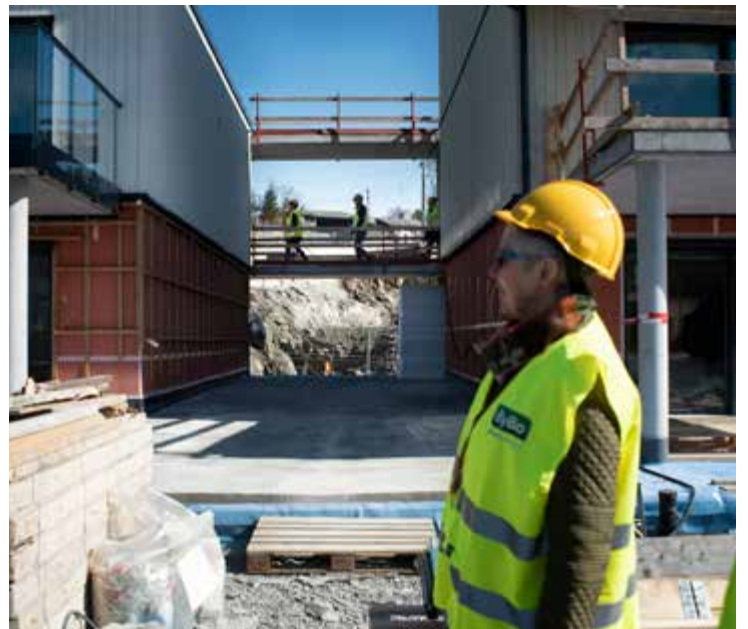
BYGGEPLASS: Solveig Irene Heimark inspiserer leilighetene i «Bukkeleitet» på Sotra som skal være innflyttingsklare i august.
